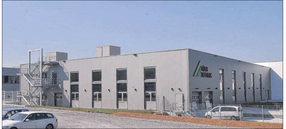
Der Erweiterungsbau mit Tiefgarage bietet genügend Raum für Wachstum.
